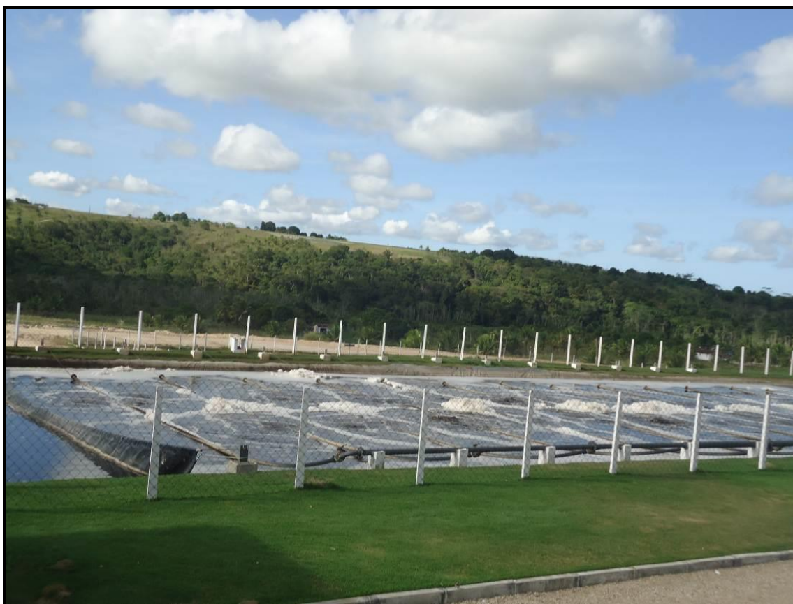
Figura 3.21. Lagoa de tratamento biológico, realizado por processo oxidação bacteriológica – Igarassu/PE. Foto: CARUSO JR., 2012.
