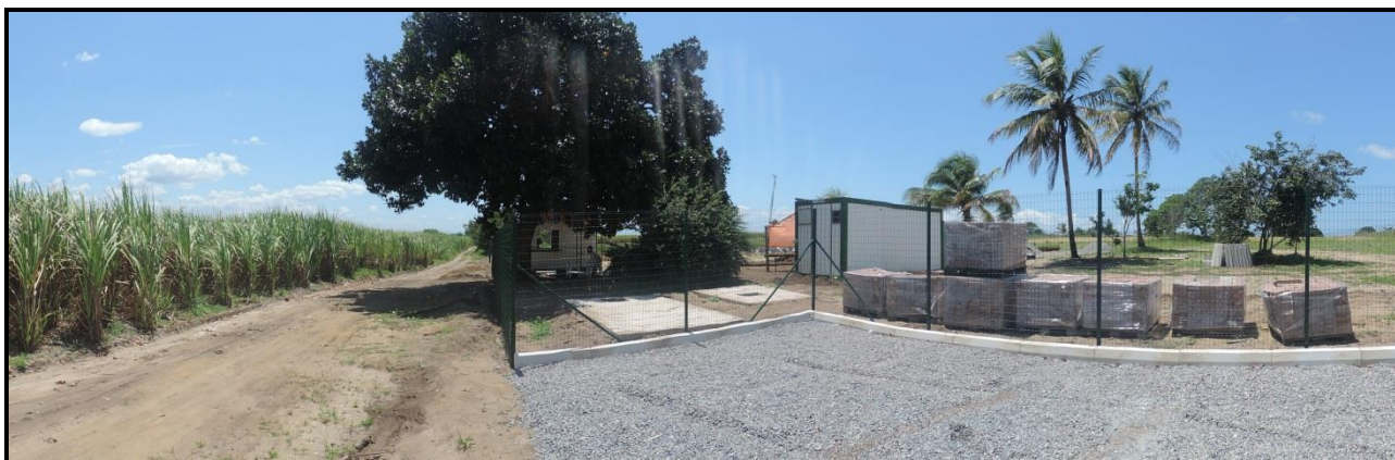
Figura 8.11. Área de implantação da Usina de Compostagem de Resíduos Orgânicos Industriais, município de Itapissuma/PE. Foto: CARUSO JR., 2014.
