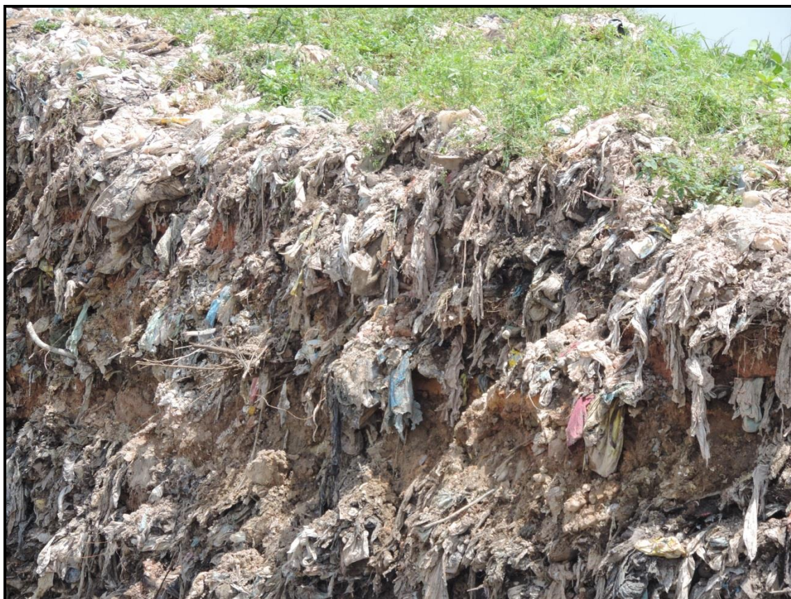
Figura 3.32. Detalhe das camadas de resíduos e de terra no lixão do município de Camaragibe/PE. Foto: CARUSO JR., 2014.
