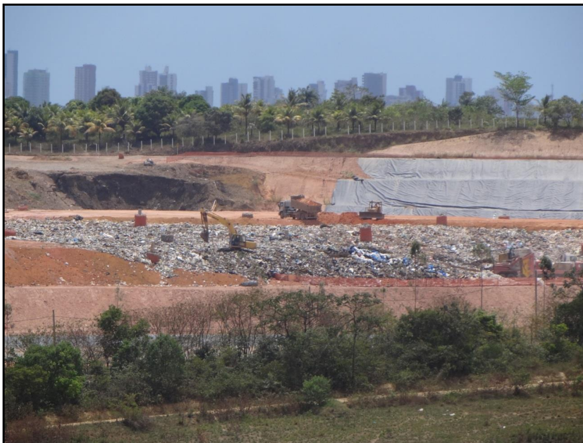
Figura 3.16. Disposição final de resíduos sólidos na Central de Tratamento de Resíduos Candeias, Município de Jaboatão dos Guararapes/PE. Foto: CARUSO JR., 2012.
