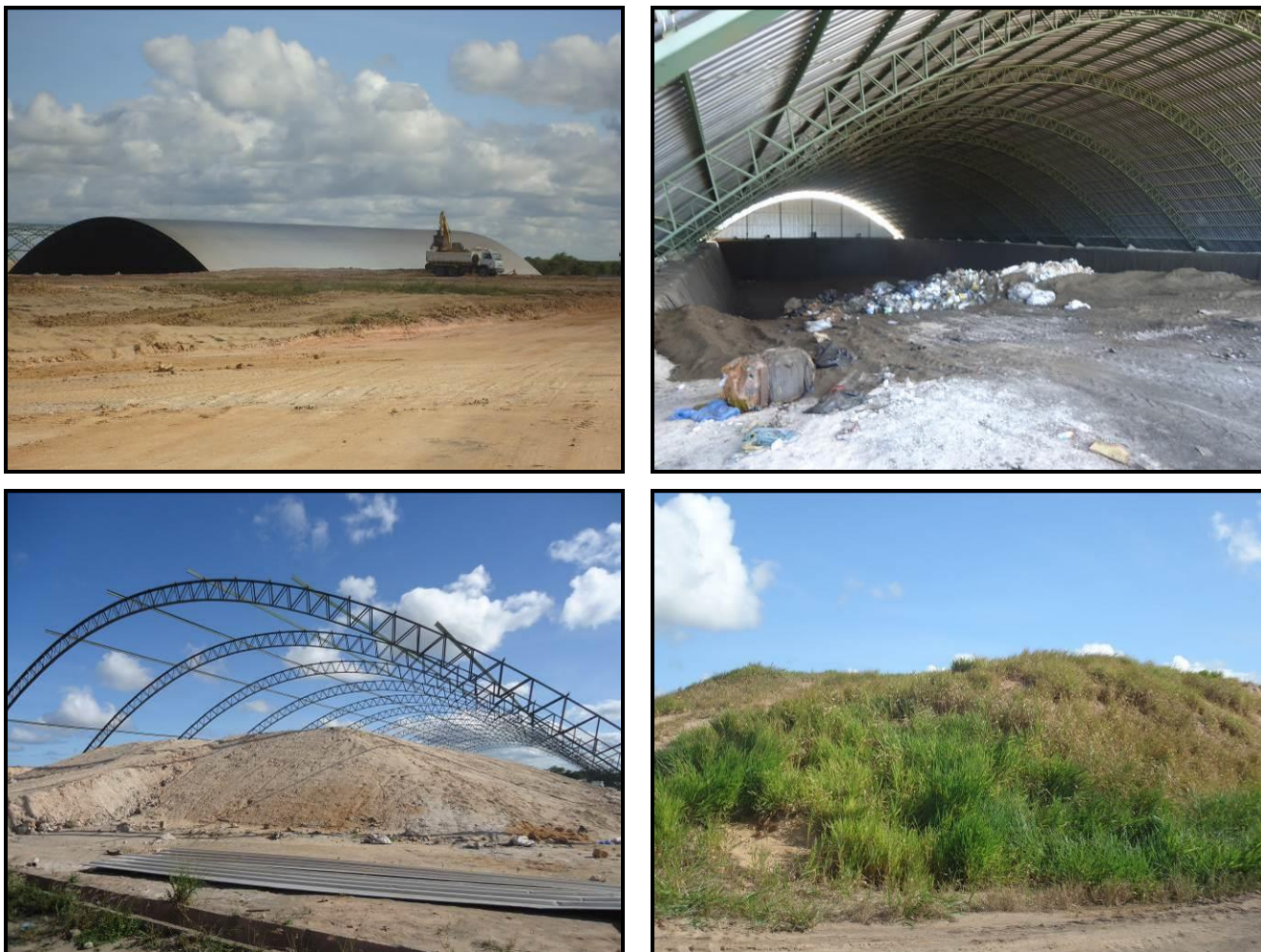
Figura 3.19. Células do aterro classe I. Célula em operação (fotos acima), célula em processo de desativação (foto abaixo, à esquerda) e célula desativa (foto abaixo, à direita) – após recuperação com gramínea – Igarassu/PE. Fotos: CARUSO JR., 2012.
