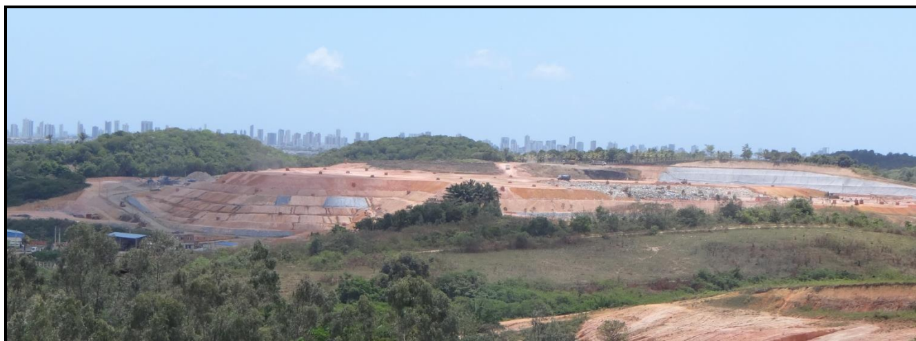
Figura 3.14. Vista da Central de Tratamento de Resíduos Candeias, município de Jaboatão dos Guararapes/PE. Foto: CARUSO JR., 2012.
