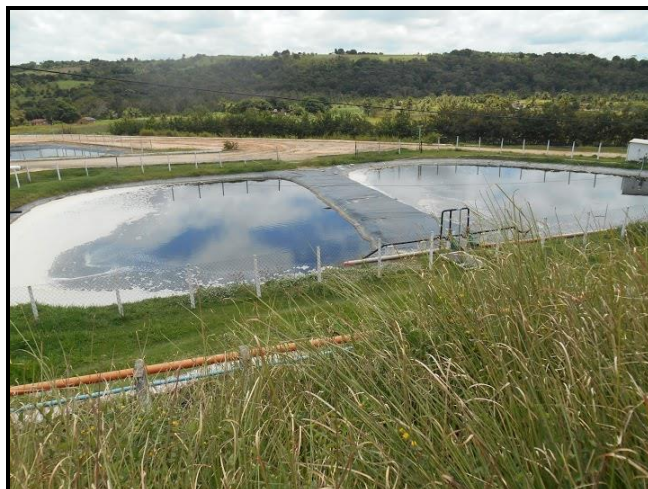
Figura 3.22. À esquerda, sistema de tratamento físico-químico, e à direita, lagoa de descarte de efluente – Igarassu/PE. Fotos: CARUSO JR., 2014.
