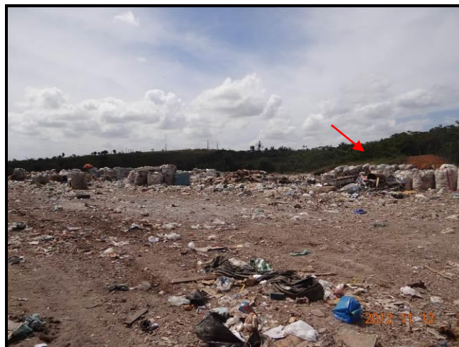
Figura 3.34. À esquerda, resíduos da construção civil, e à direita, vários sacos (big bags), indicada pela seta vermelha, onde são armazenados temporariamente os materiais recicláveis, após serem triados no próprio lixão – São Lourenço da Mata/PE. Foto: CARUSO JR., 2012.
