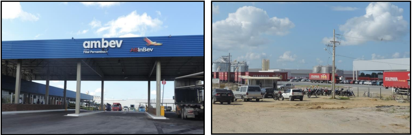
Figura 8.8. Fábrica da Ambev (à direita) e da Itaipava (à esquerda), indústrias do ramo de fabricação de bebidas no município de Itapissuma/PE. Foto: CARUSO JR., 2014.
