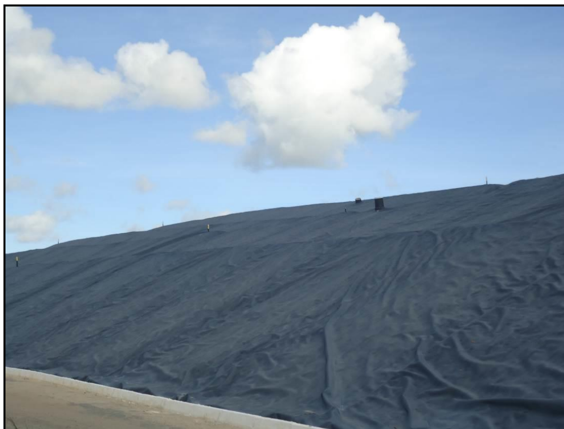
Figura 3.20. Manta de PEAD utilizada na impermeabilização do aterro – Igarassu/PE. Foto: CARUSO JR., 2012.
